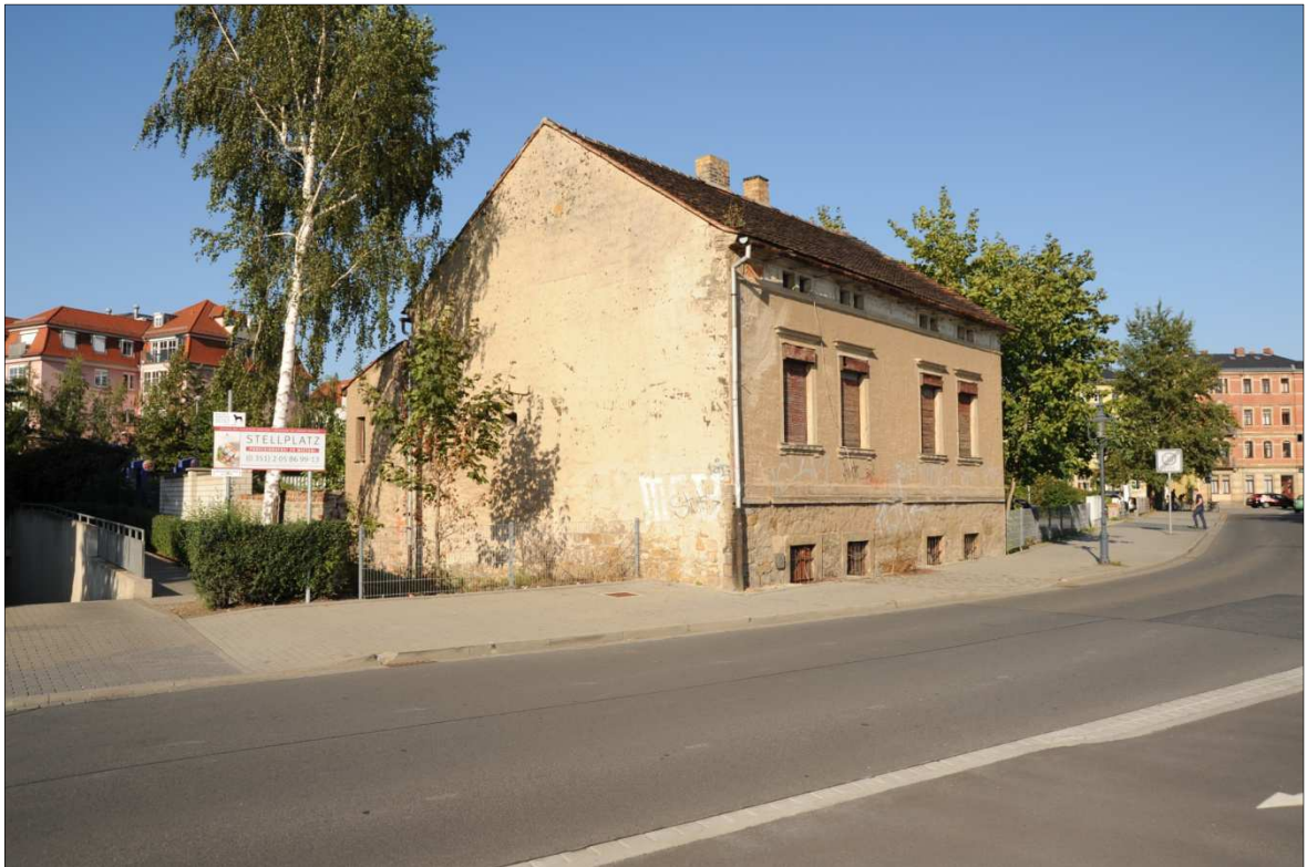
Bild 17: Gebäude Kötzschenbroder Straße 6
